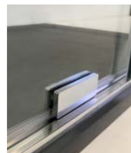
Rodamiento integrado en hoja
