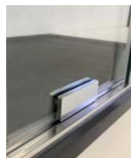
Rodamiento integrado en hoja
